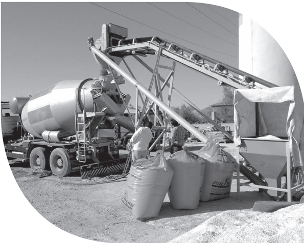
Preparation in concrete batching plants Préparation en centrale à béton
