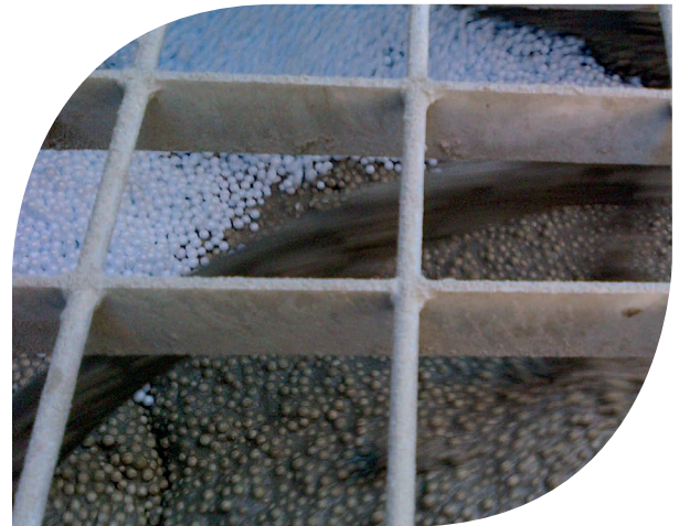
Preparation in concrete mixer Préparation à la bétonnière
